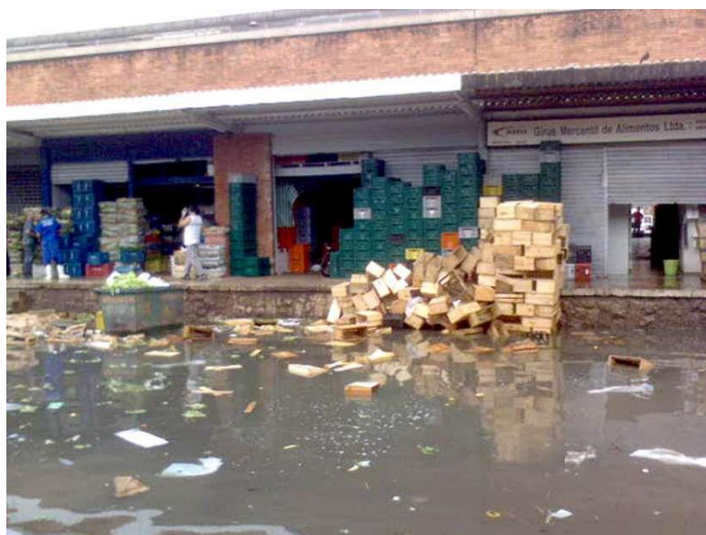
Figura 9 - Problemas com enchentes na CEAGESP
